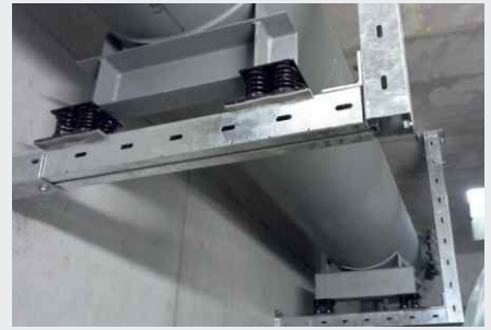
Isolation de conduits d'échappement
