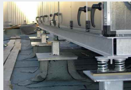
Installation VMC sur toit
